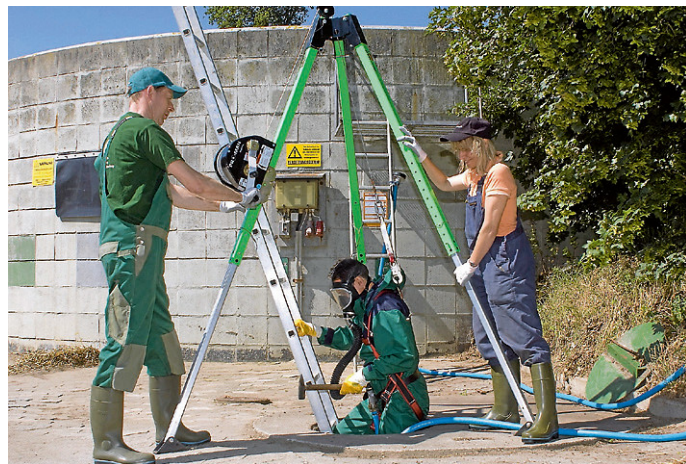
So gelingt der sichere Einstieg in die Güllegrube
